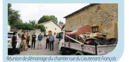
Réunion de démarrage du chantier rue du Lieutenant François
