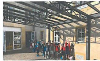
Ce préau tant attendu est enfin installé, inspiré par G. Eiffel, notre prestataire a conçu, fabriqué et monté ce préau de 8 x 5 m parfaitement intégré à l'arrière de la mairie, recouvert d'un toit en verre solaire.
