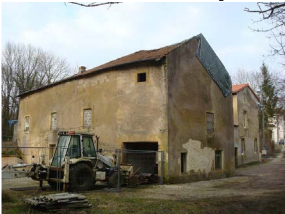
Vue C – (2015) Vue de la façade sud du Moulin de Goglo en cours de réhabilitation.
